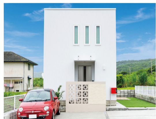
“箱”の中をデザインできる自由さと、建物としての安心を備えたローコスト木造建売住宅
